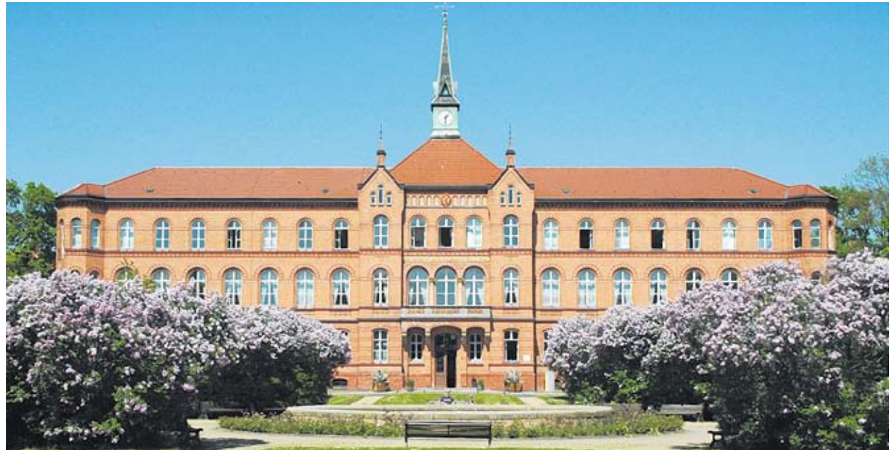
Das Hauptgebäude des Evangelischen Krankenhauses Königin Elisabeth Herzberge (KEH) ist ein imposanter Klinkerbau.
